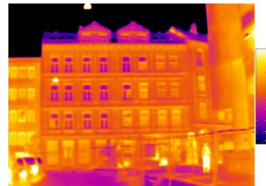
Kontroll av fasade
